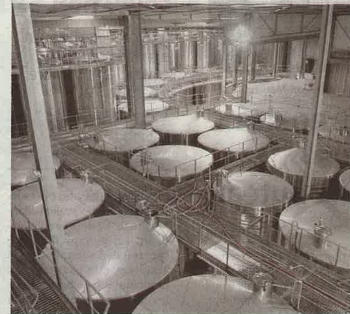
La nouvelle cave abrite près de 150 cuves en inox. MICHAËL ESDOURRUBAILH
